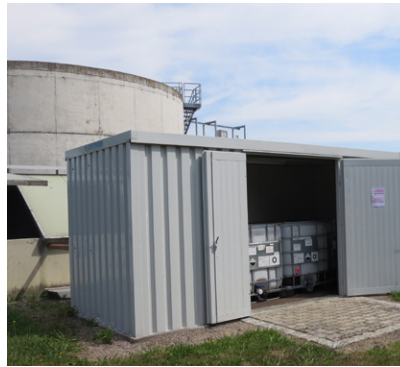
Abb. 4: Fällmittellagercontainer
